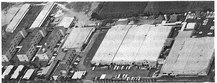
佐賀工場全景
